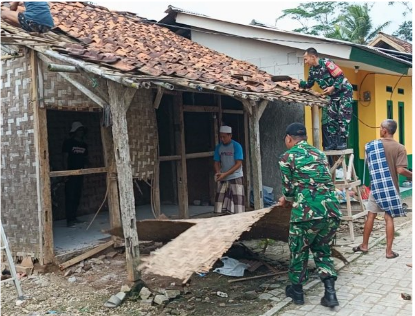
Pembongkaran Rumah Bapak Narmin
